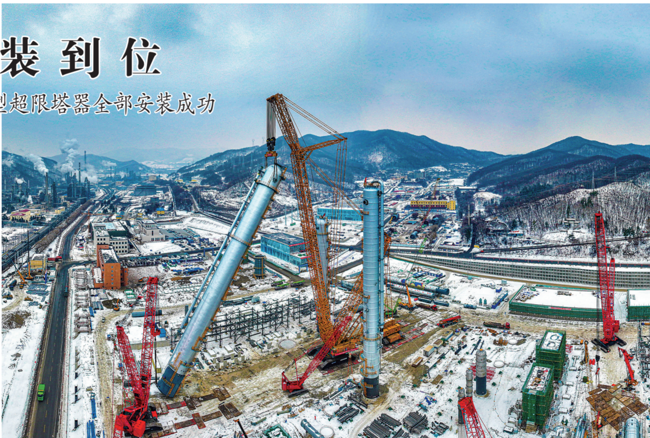
1月18日,吉林石化公司炼油化工转型升级项目年产120万吨乙烯装置2号丙烯塔顺利吊装就位。 本报记者 石雷 摄
