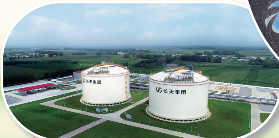
长春市城市LNG应急调峰储备站项目。
