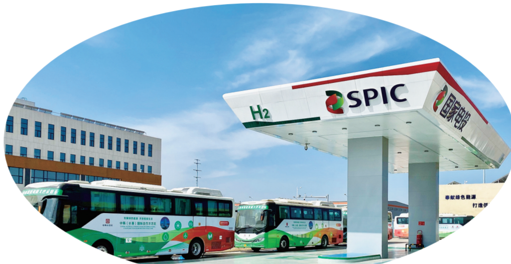
吉林长春氢源母站——中韩示范区“可再生能源+制氢+加氢”一体化示范项目。
