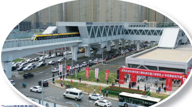
▼城市轨道交通4号线南延-福祉大路站。
