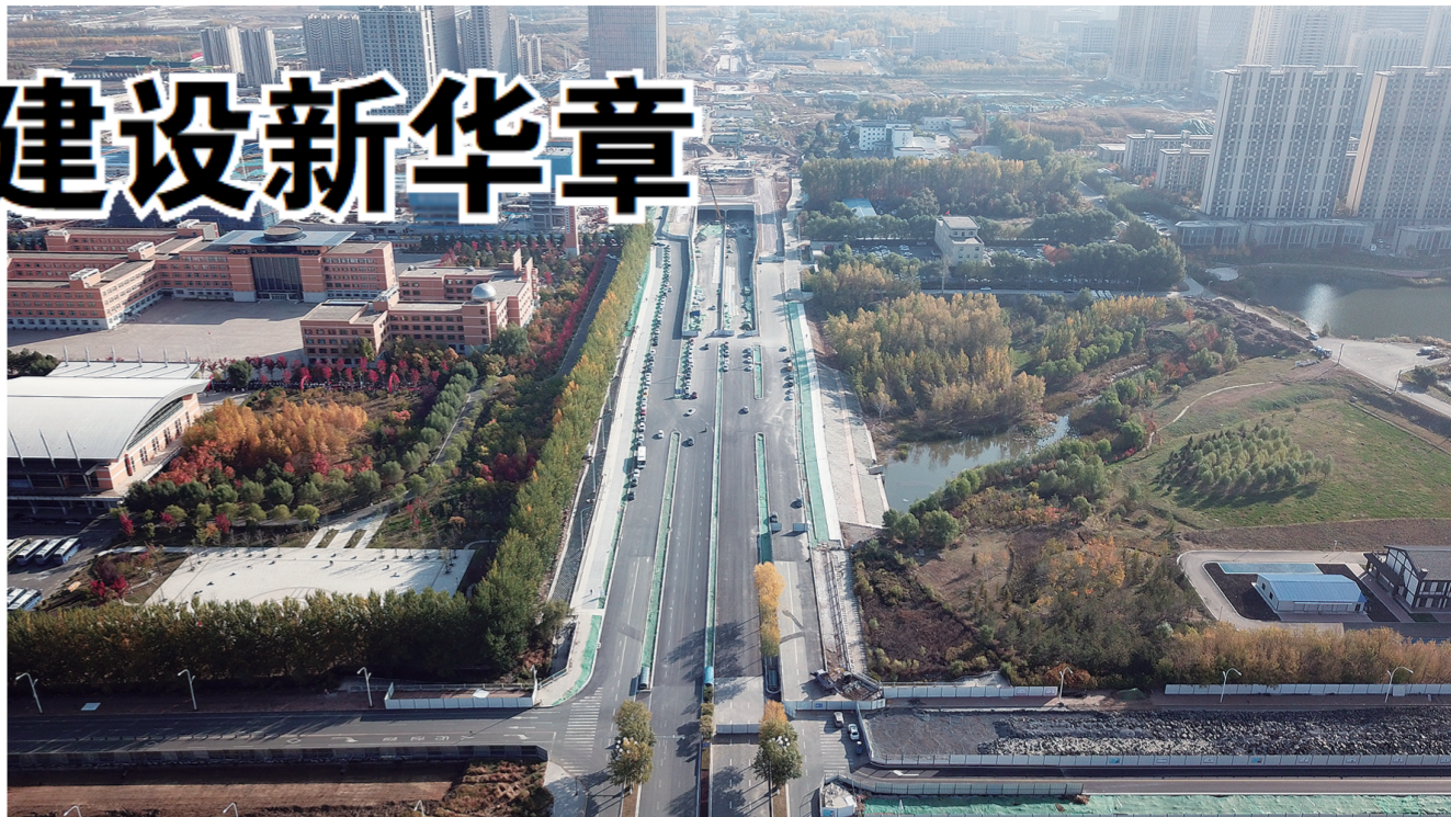
人民大街下穿隧道结构主体完工。
