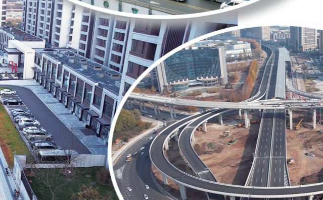
▲工农大路建设街天桥。
