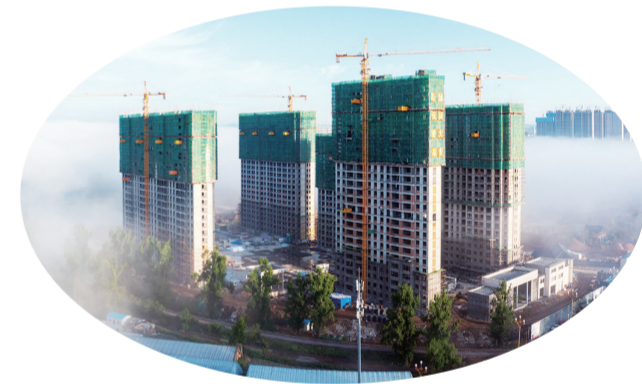
项目建设挺起延边高质量发展“硬脊梁”。延边州委宣传部供图
