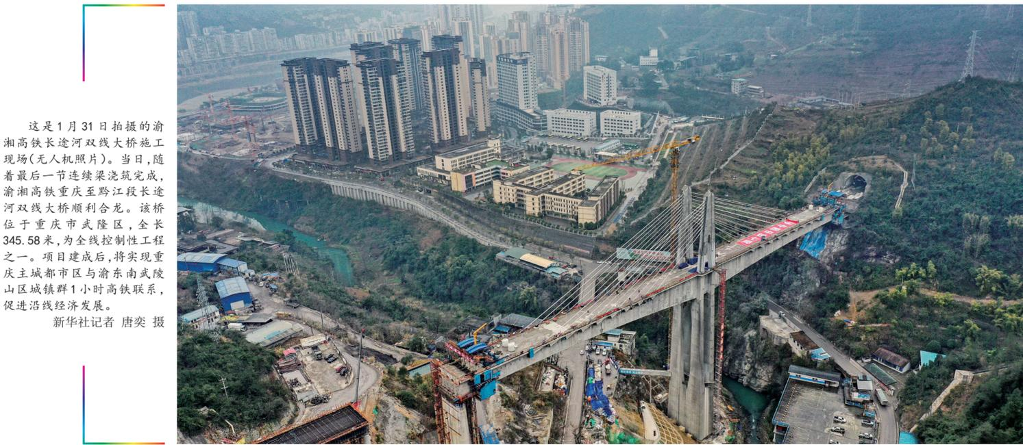
这是1月31日拍摄的渝湘高铁长渝河双线大桥施工现场(无人机照片)。当日,随着最后一节连续梁浇筑完成,渝湘高铁重庆至黔江段长渝河双线大桥顺利合龙。该桥位于重庆市武隆区,全长345.58米,为全线控制性工程之一。项目建成后,将实现重庆主城区与渝东南武陵山区城镇群1小时高铁联系,促进沿线经济发展。
