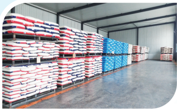
吉林省松江佰顺米业有限公司仓储库房改造提升。
