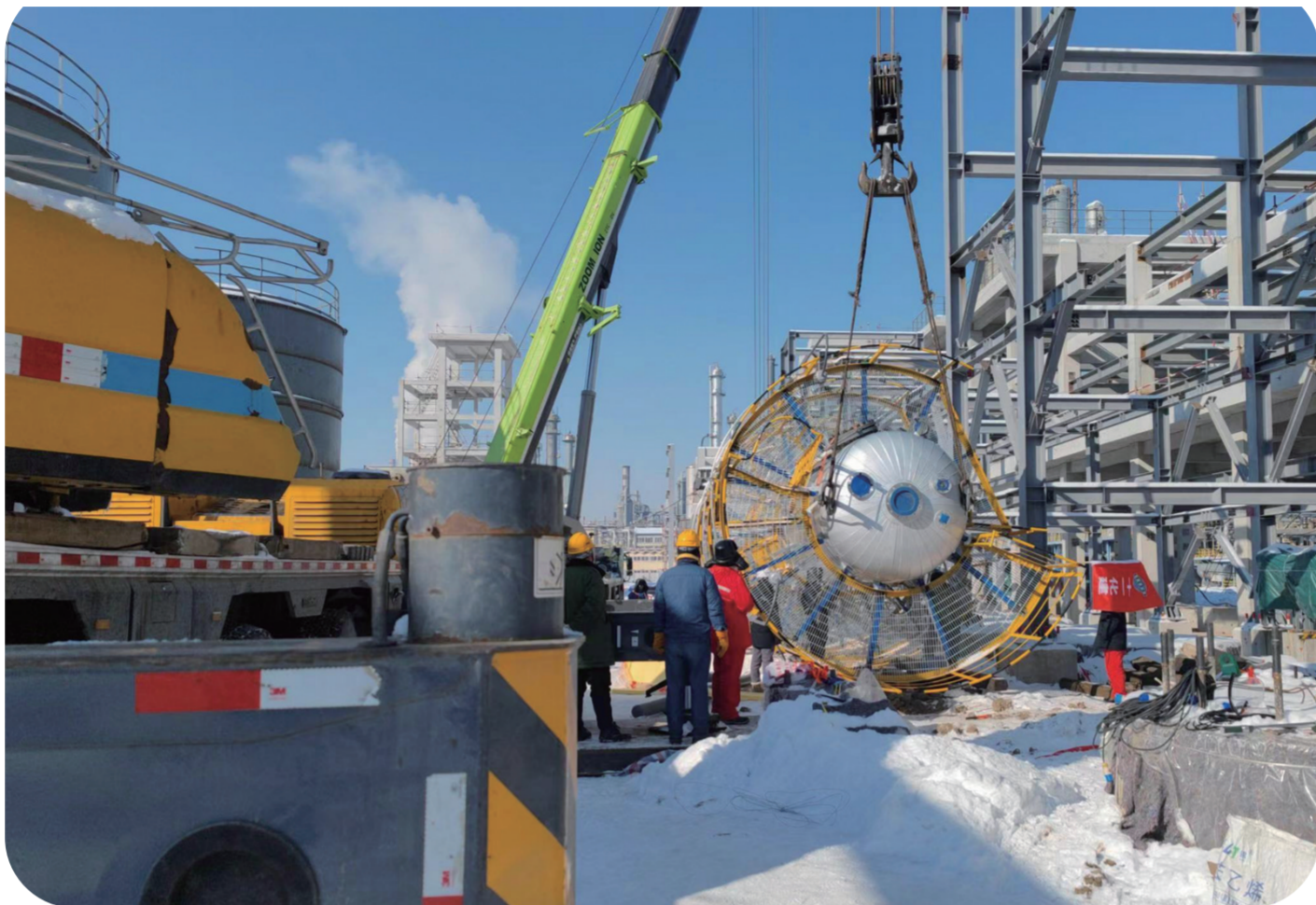
吉林石化炼油化工转型升级年产4万吨乙丙橡胶装置单体闪蒸塔T-5201吊装现场。
