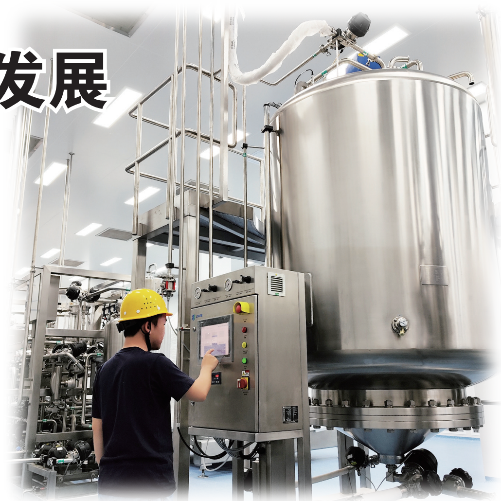
春节过后,通化安睿特生物制药重组人白蛋白生产基地一期工程项目的施工人员迅速投入建设当中。
