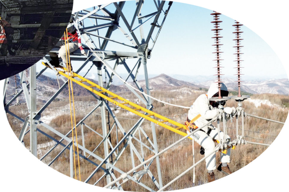
国网白山供电公司成立项目供电服务推进小组,对全市项目按性质、负荷特点、建设工期等确定配套电网项目包,并进行跟踪服务,全力推动项目建设。图为工人正在作业,保障沈白高铁建设用电不间断。赵洪清 摄
