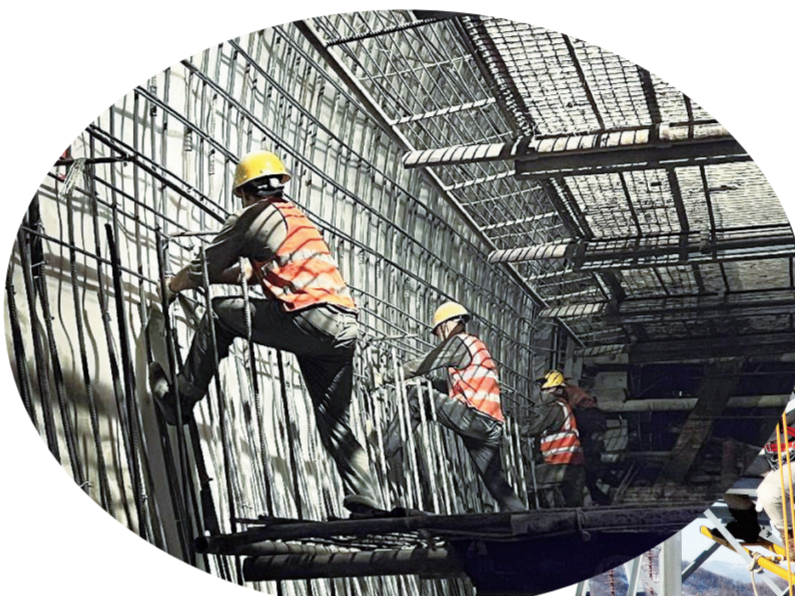
▲春节刚过,中铁上海工程局沈白高铁吉林段TJ-5标项目部有序组织500余名建设者奋战一线,全力冲刺一季度“开门红”。图为工人们正在铺设隧道防水板。徐孝忠 摄
