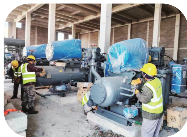
工人们正在安装冷库制冷主机。
