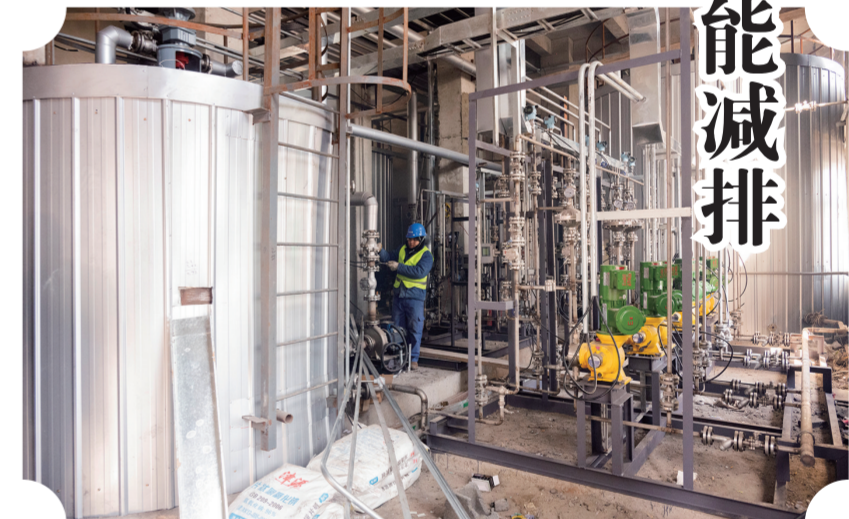
工人们正在对新升级的供暖设施进行安装调试。
