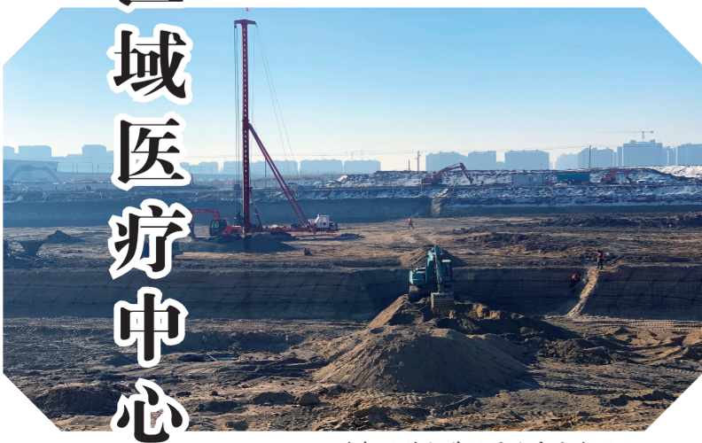
首都医科大学附属北京安贞医院吉林医院项目现场。
