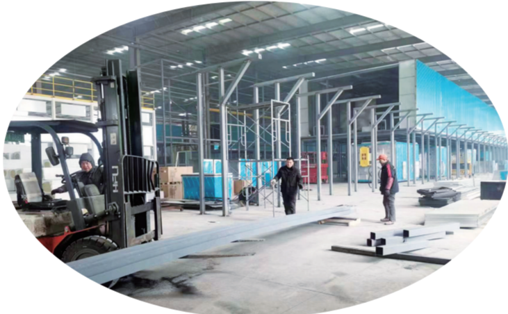
产业园一期工程正在进行厂区内配套基础设施建设和设备的调试。
