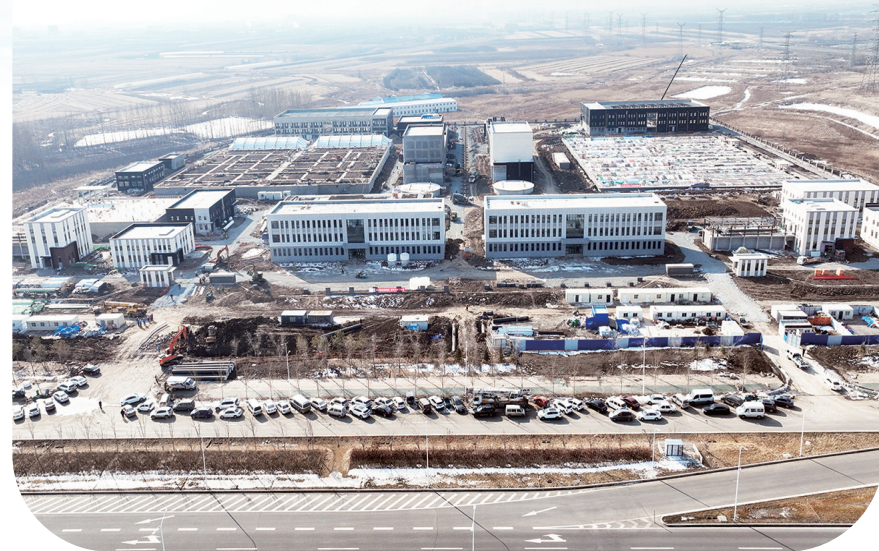
污水处理厂主体设备安装进入收尾工作。
