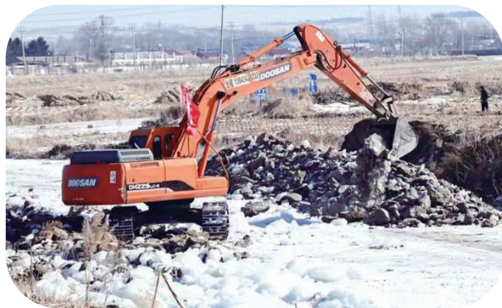
在衬砌明渠作业现场,大型机械繁忙施工,项目建设有序推进。
