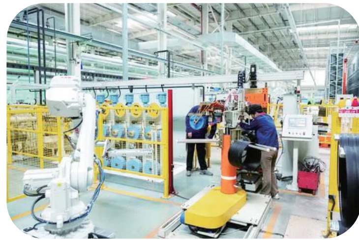
工作人员正在调试新安装设备。
