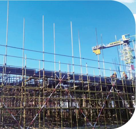
工人们正在搭设脚手架准备对楼体外立面进行施工。
