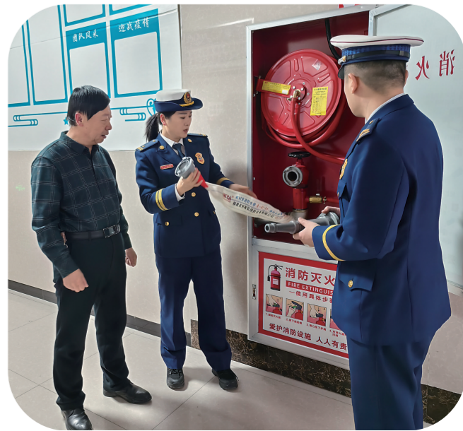
日前,四平市消防救援支队红开大队对辖区内人员密集场所常用消防产品进行全面检查,确保消防产品安全。刘芮伊 摄
