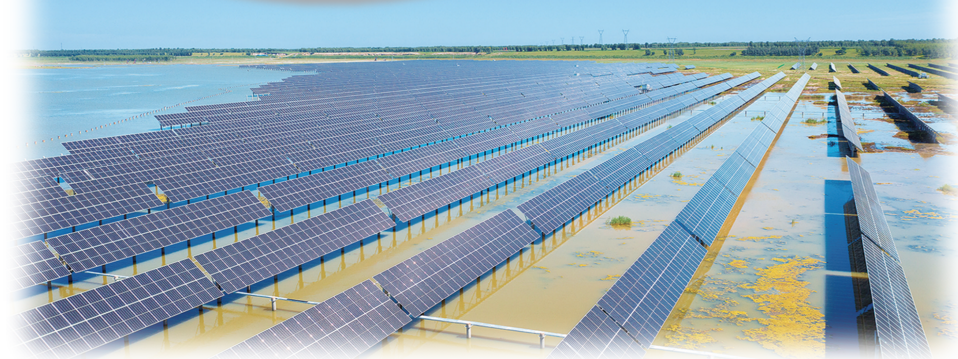
推进渔光互补发电项目建设,形成“上可发电、下可养鱼”的发电新模式,产生多重效益。图为乾安渔光互补项目。
