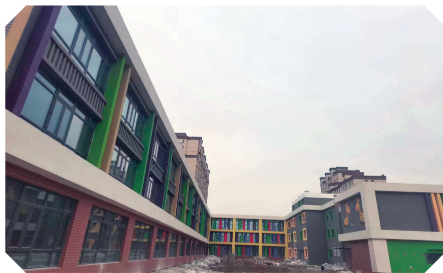
公主岭市范家屯镇幼儿园项目正加紧进行内部装饰工程。
