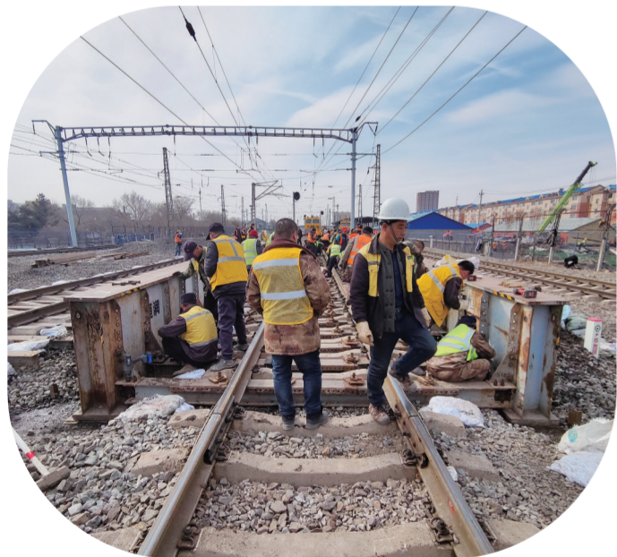
工人们正在进行铁路框构桥扩宽工程施工。
