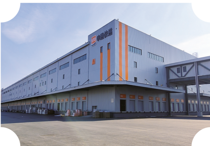
申通公主岭市智慧物流产业园项目(一期)预计10月投入运营。
