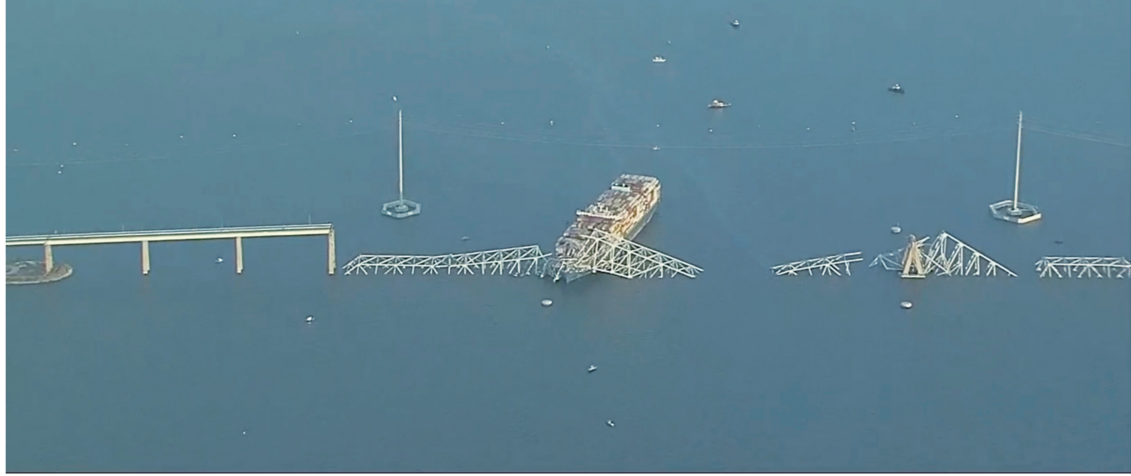
这是3月26日在美国巴尔的摩拍摄的遭撞击后坍塌的“弗朗西斯·斯科特·基”大桥和撞击大桥的集装箱船。
