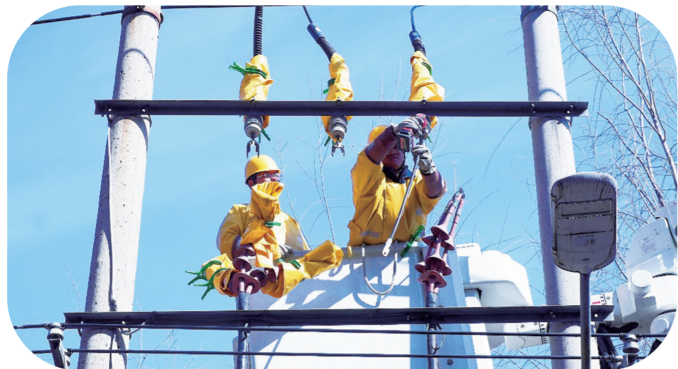
日前，国网长春供电公司积极开展春检，对10千伏春菊线开展带电作业排除线路隐患。王春晖 摄
