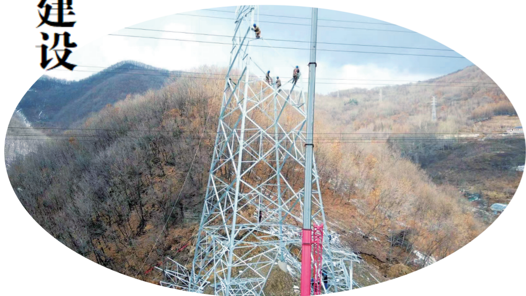
国网通化供电公司220千伏通桃甲、乙线53号组塔现场。刘宇 摄
