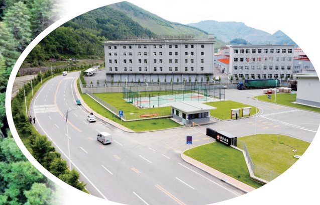
白山市农村公路总里程达5300公里，占全市公路总里程的77%以上，为深度实施乡村振兴战略奠定坚实的交通运输保障基础。
