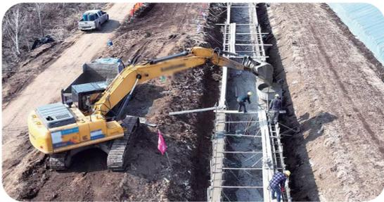
今春以来,敦化市水利部门抢抓工期加快农业灌区续建配套与节水改造工程建设步伐,力保在5月10日前全部完成工程建设任务,确保辖区2个灌区2790公顷水田及时得到春耕生产灌溉供水。图为敦化市贤儒灌区续建配套与节水改造工程“矩形槽”混凝土浇筑现场。敦化市委宣传部供图
