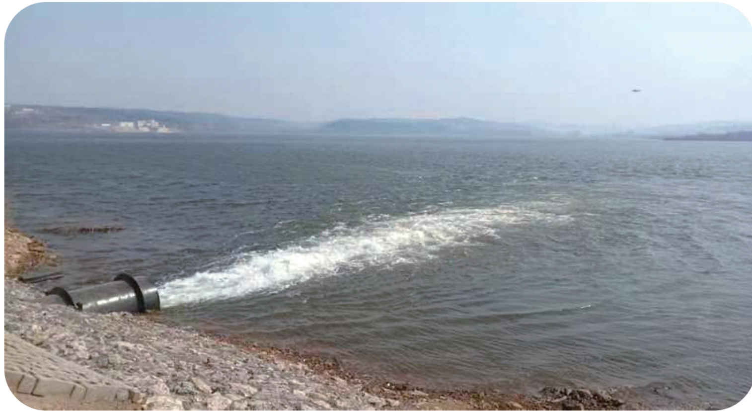
四平下三台水库出水口。
