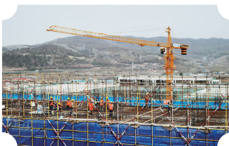
吉林化工学院丰满校区恢复施工。
