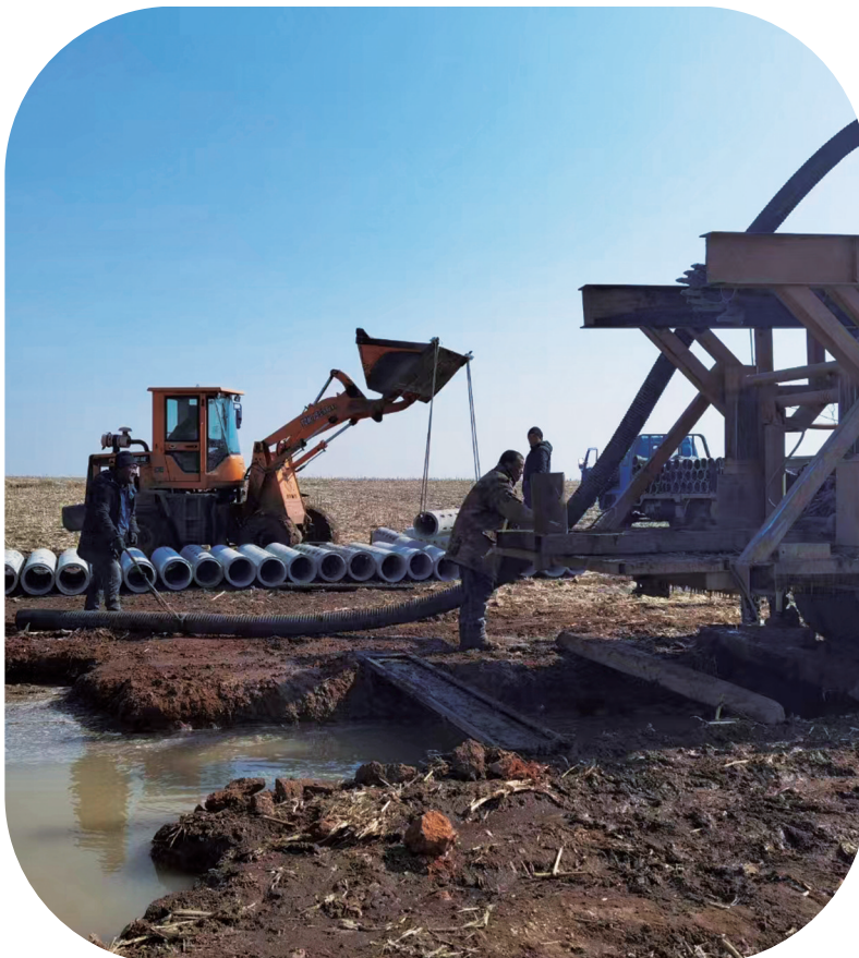
长岭县水肥一体化大田施工现场。 本报记者 王春胜 摄
