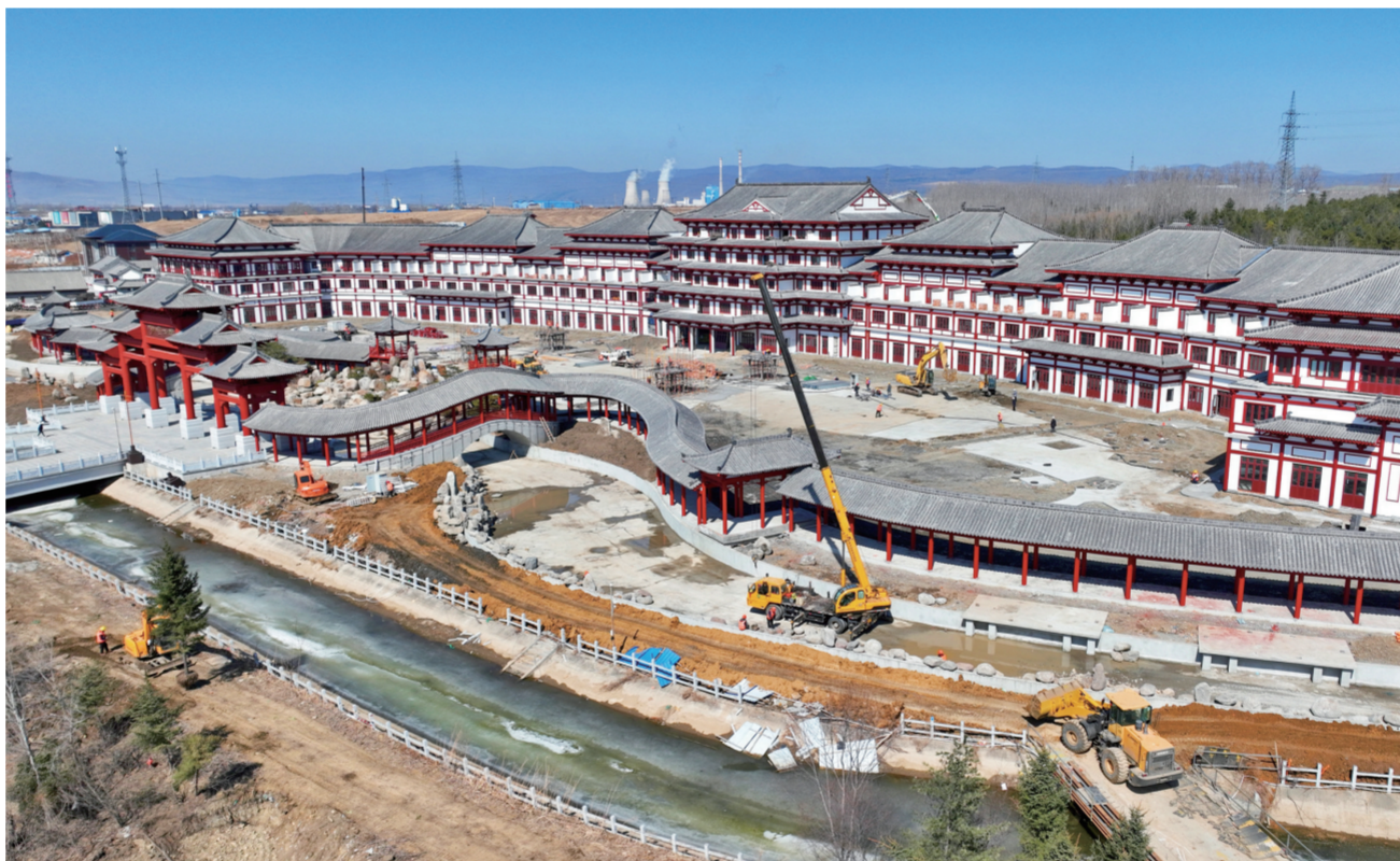
近年来,珲春市持续加强文化旅游基础设施建设,大力发展乡村旅游的重要标志性项目,打造特色边境游、跨国游、生态游。图为珲春丝绸之路渤海古镇旅游基础设施项目施工现场。
