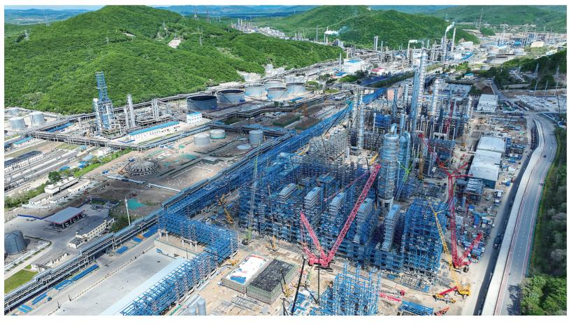
日前,在中国石油吉林石 化公司炼油化工转型升级项 目 120 万吨/年乙烯装置建设 现场,乙烯装置全面进入设备 安装和工艺管线安装阶段,这 是吉林石化公司炼油化工转 型升级的最关键装置,建成后 将带动吉林石化乙烯产业链
