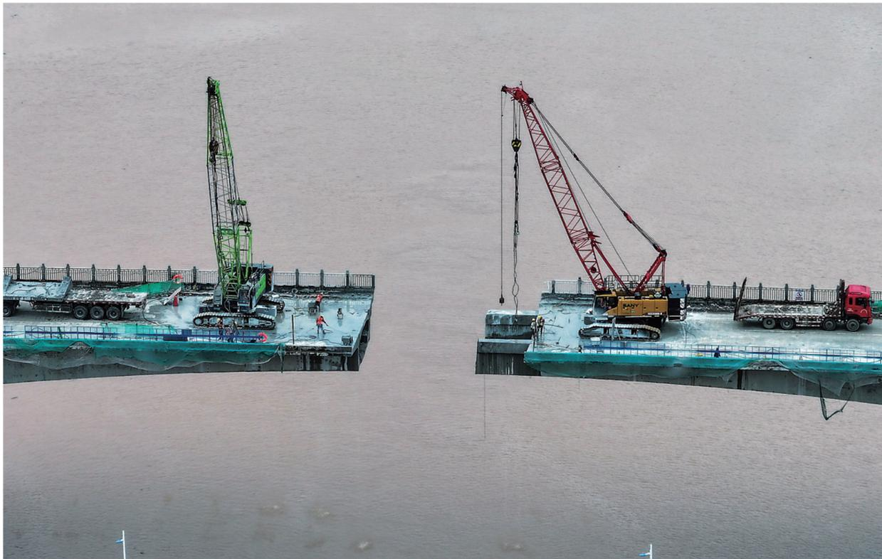
5月26日，在钦州市钦江江面上，施工队在拆除钦江三桥(无人机照片)。近日，广西平陆运河建设施工队伍抢在汛期来临前，开展拆除钦江面老桥、疏浚河道等工作。
