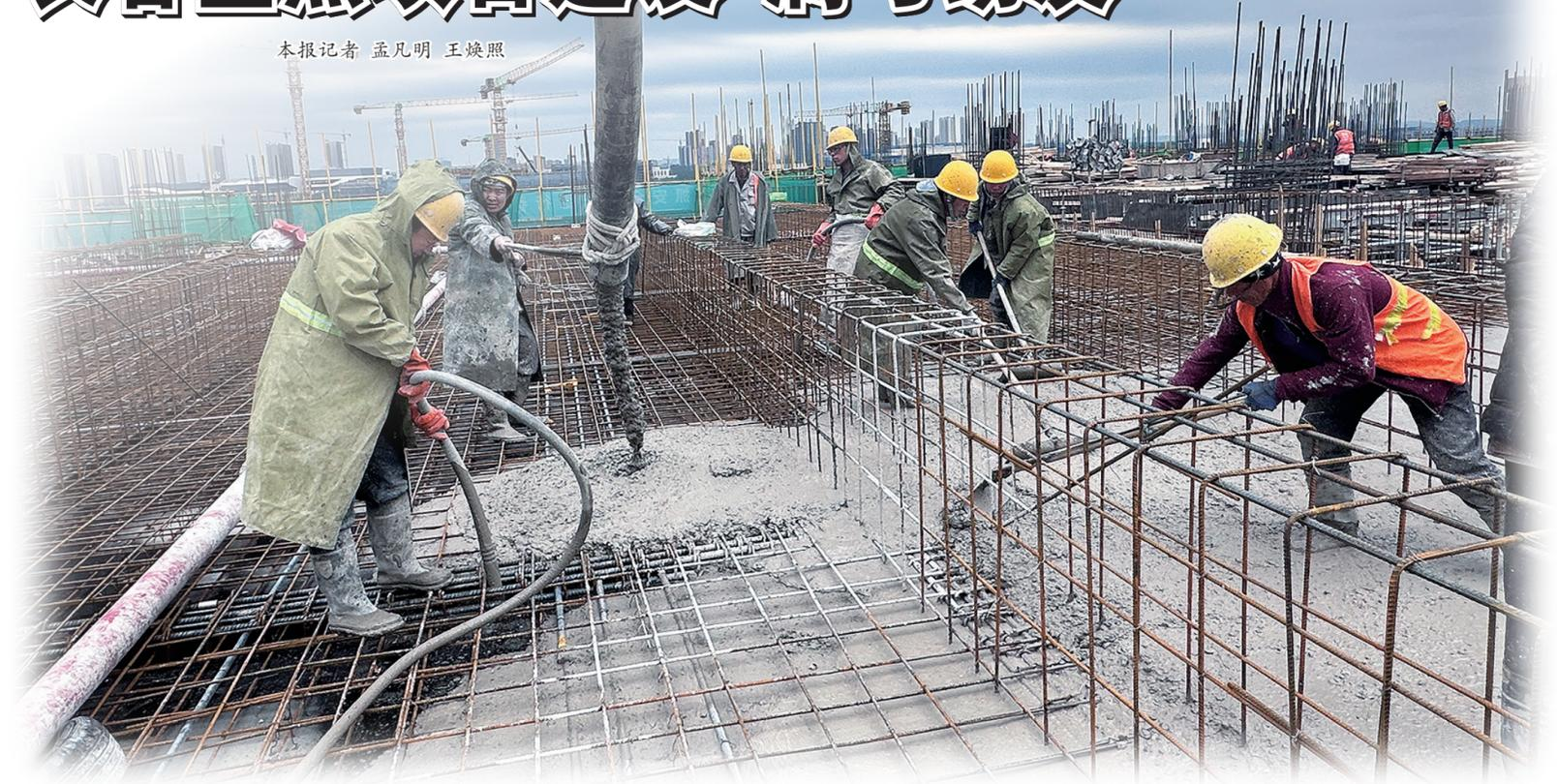
北京安贞医院吉林医院项目首段封顶，项目主体结构建设进入冲刺期，图为建筑工人正在浇筑4层顶板混凝土现场。
