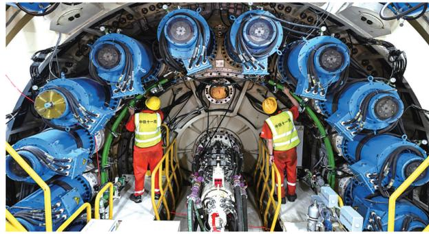
5月30日，施工人员在检查“鲲鹏号”盾构机刀头组件运行状况。当日，深江铁路深莞隧道西段“鲲鹏号”盾构机顺利始发。该段是13米级大直径单洞双线隧道，线路埋深跨度在9至62米。该工程建成后，深圳与江门可实现1小时内通达，深圳与广州南沙自贸片区可实现半小时高铁互联互通。新华社记者 刘大伟 摄
