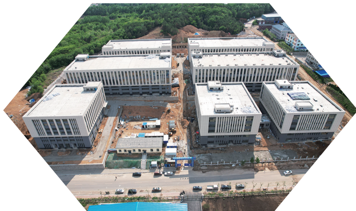
吉林都市工业园二期主体施工完成。
