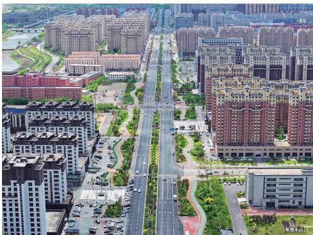
舒兰市舒兰大街改造工程加快建设。
