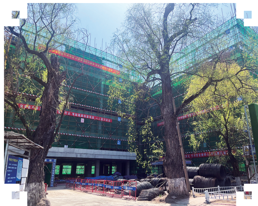
东北电力大学储能技术研究中心项目封顶。
