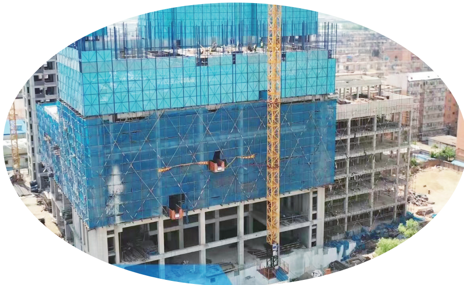
桦甸市华宇国际酒店项目即将完工。
