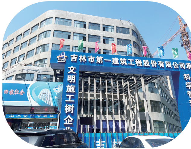
吉林市中心医院省域优质医疗资源扩容下沉项目进入内部施工阶段。
