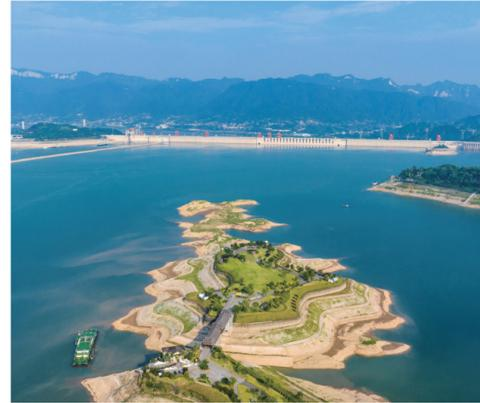
6月6日在湖北省宜昌市秭归县拍摄的水位下降后的三峡大坝，三峡水库水位下降后的消落带清晰可见（无人机照片）。当日8时，三峡水库水位消落至145米，提前4天完成消落任务。这意味着三峡水库已腾出221.5亿立方米防洪库容，正式转入汛期防洪调度。
