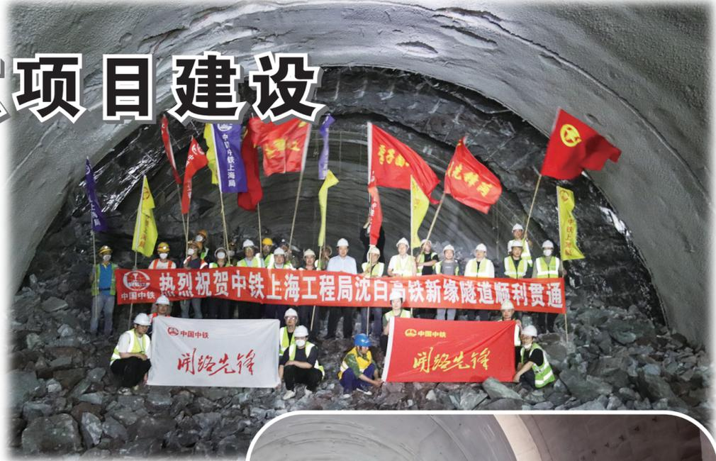
▲6月16日,历经3年的施工建设,由中铁上海工程局承建的沈白高铁新线隧道顺利贯通。新线隧道位于白山市,为单洞双线隧道,全长4724.9米,最大埋深181.71米,为高风险长大隧道。
