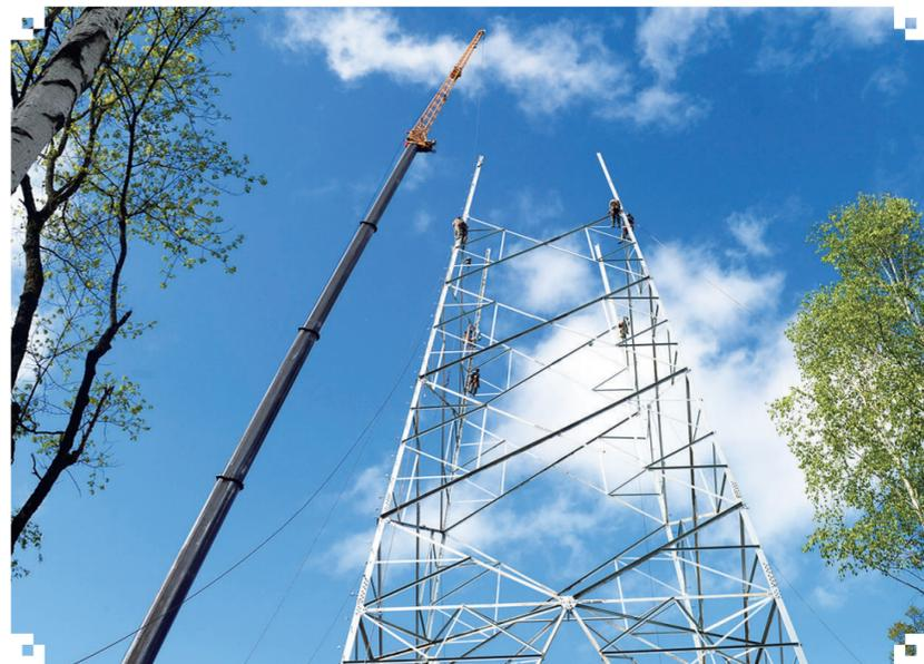
国网白山供电公司抢抓施工有利时机,加快沈白高铁牵引站输电工程建设。图为该公司为沈白高铁浑江牵引站建设220千伏输电线路铁塔。
