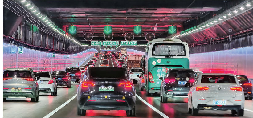
这是开通首日的深中通道海底沉管隧道内的车流(6月30日摄)。6月30日,历时七年建设的国家重大工程深中通道正式通车运营,从深圳到中山的车程从原来的2小时缩短至30分钟。新华社记者 刘大伟 摄
