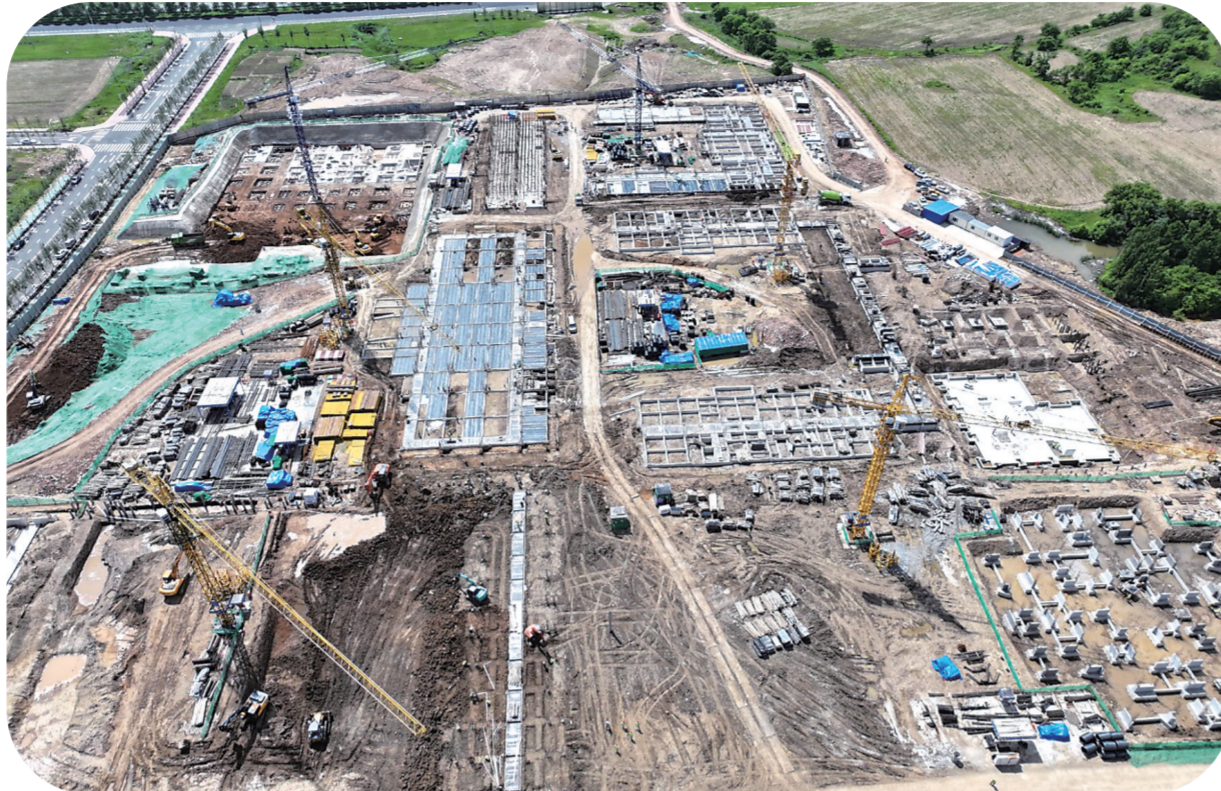
长春莲花山梦想国项目施工现场。
