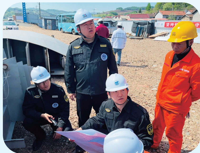
验船师现场指导施工作业。
