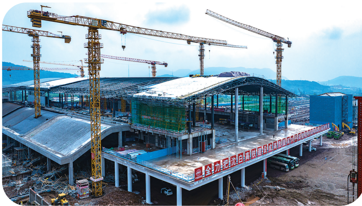
沈白高铁通化西站正在建设中,目前已进入百日冲刺关键阶段。
