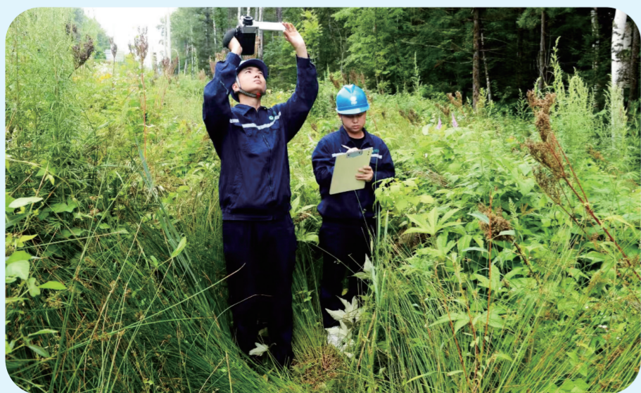
汛期来临,国网白山供电公司组织开展设备巡视检查,消除各类供电安全隐患,保障可靠供电。图为工作人员巡视长白山脚下的10千伏山门甲线路。 赵洪涛 摄
