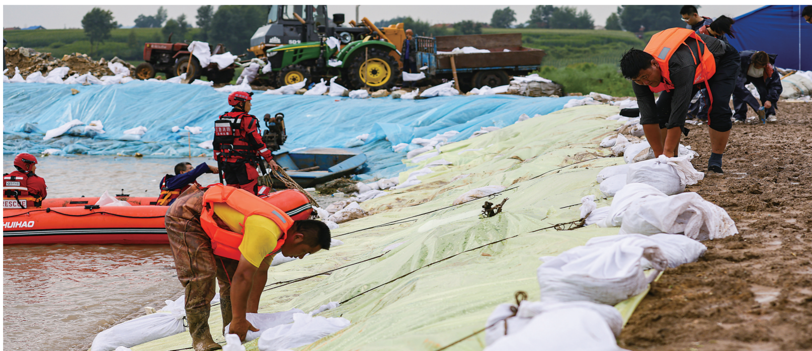
连日来，我省各地各部门迅速组织力量防汛固堤，广大干部群众迅速响应、积极配合。图为农安县防汛人员对马河靠山镇段丁字堤、卧牛石堤坝进行加固。 本报记者 潘硕 摄
