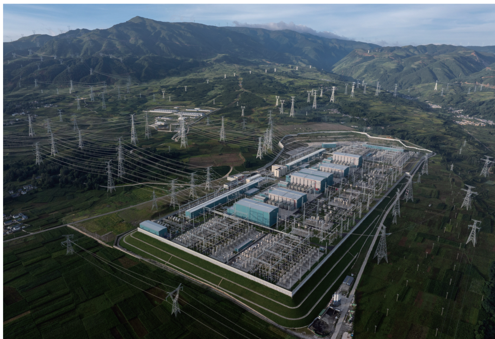
俯瞰布拖换流站(7月23日摄，无人机照片)。 记者从国家电网四川省电力公司获悉，近日，国网四川电力布拖换流站达到1600万千瓦满功率运行状态，这是该换流站全面投运一年以来的首次，证明其完全能够消纳白鹤滩水电满发所生产的清洁能源。 新华社记者 江宏景 摄
