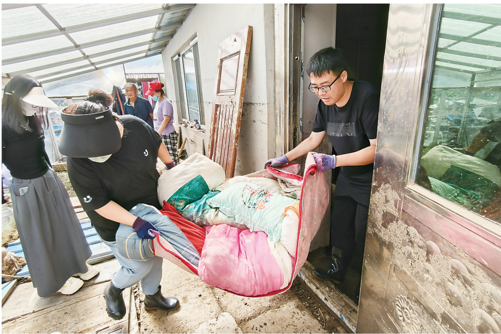
连日来,临江市大栗子街道党工委组织街道机关干部、村(社区)工作人员、志愿者快速投入到汛后恢复工作中,全面勘察摸排辖区农田水利、生产设施、道路设施、房屋建筑等水毁受损情况,协助农户开展农业保险申报,最大限度减少群众财产损失。
