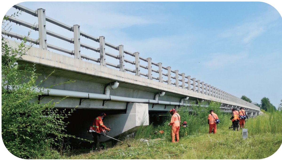
强降雨过后，永吉县公路段第一时间组织技术人员对辖区桥梁进行全面排查，重点检查桥梁外观、排水设施、伸缩缝、桥梁结构有无异常，桥梁支座、桥位段河床冲刷变化及桥梁基础是否受到冲刷损坏等情况。本报记者 邹鹏亮 摄
