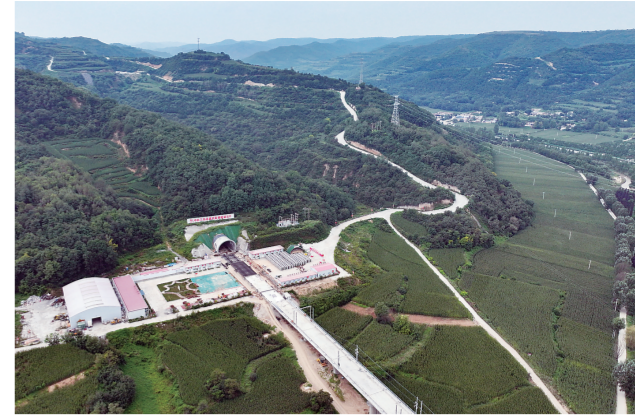
这是西延高铁武家塬隧道出口(8月25日摄，无人机照片)。当日，由中铁三局承建的西(安)延(安)高铁武家塬隧道顺利贯通。武家塬隧道位于陕西省铜川市宜君县，全长约9.7千米。建成投入运营后，西安至延安的铁路运行时间将从目前的2.5小时缩短至1小时左右。新华社记者 张博文 摄
