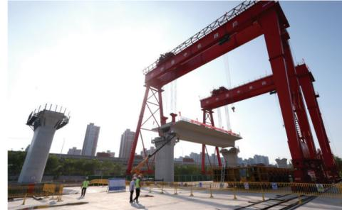
8月26日拍摄的沪渝蓉高铁上海段首榀箱梁架设施工现场。当日,由中铁四局承建的沪渝蓉高铁上海段首榀箱梁架设完成,标志着该段正式进入桥梁架设阶段。新华社记者 方喆 摄
