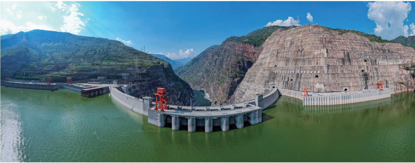
这是8月28日拍摄的白鹤滩水电站(无人机全景照片)。白鹤滩水电站位于云南省巧家县和四川省宁南县交界处金沙江干流,是我国实施“西电东送”的国家重大工程。白鹤滩水电站是世界第二大水电站,安装有16台100万千瓦水轮发电机组,机组水力设计、电磁设计、通风冷却、高性能材料研发应用达到世界领先水平。
