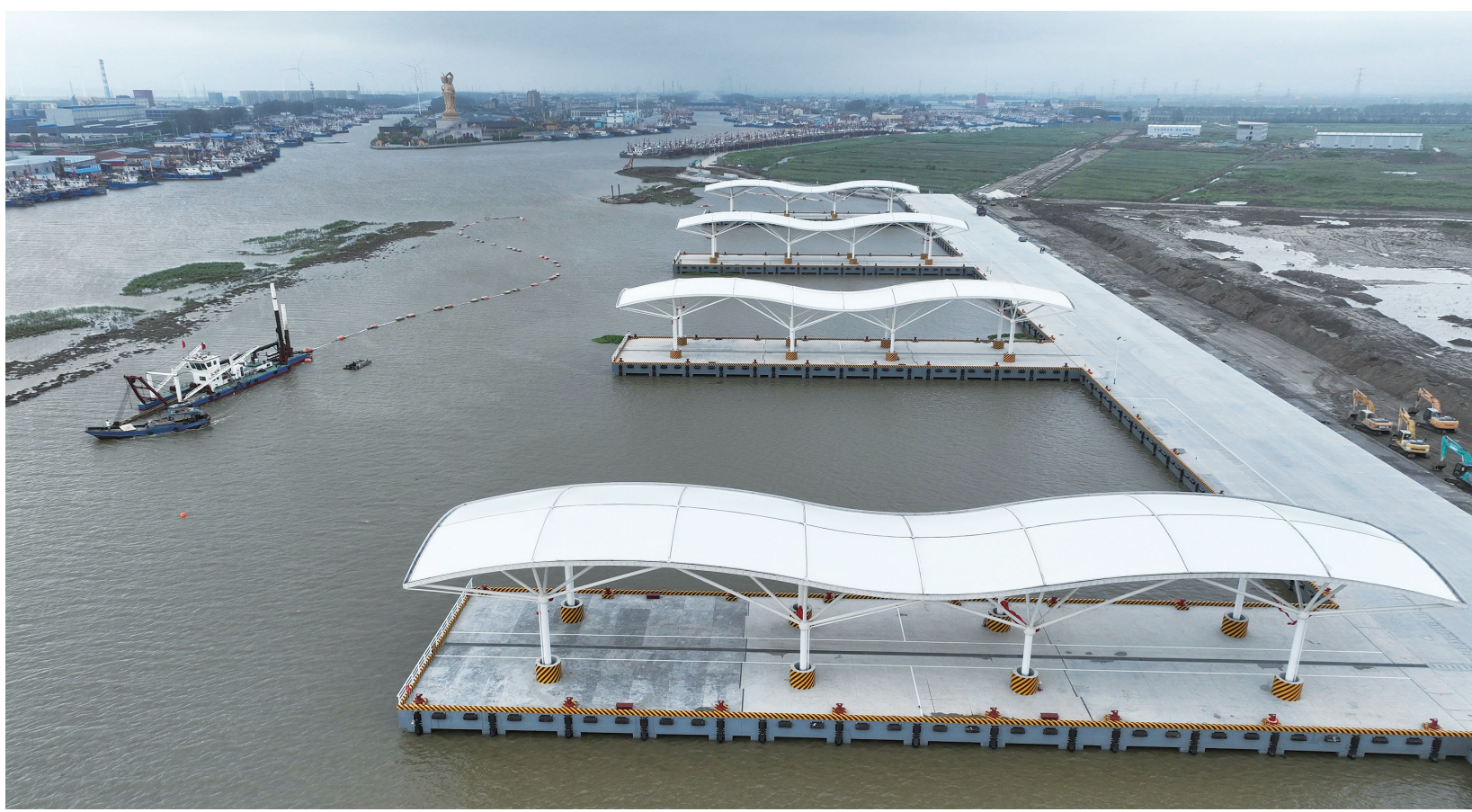
9月16日拍摄的黄沙港(无人机照片)。当日,由中国铁建投资集团牵头,中铁十六局集团、中国铁建港航局集团参建的盐城黄沙港国家中心渔港二期码头正式启用。该码头为全国首座全自动化渔业码头,将在国内率先拥有全自动智能卸货功能,并逐渐配套建成水产品交易、冷冻仓储、渔需物资仓储、制冰加水等功能区,提升码头作业效率,降低渔船补给成本。
