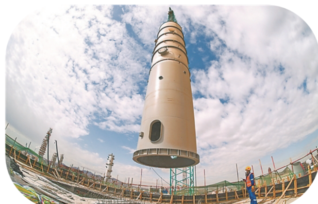
吉林石化炼油化工转型升级项目26万吨/年丙烯腈装置硫磺浓缩塔完成安装。
