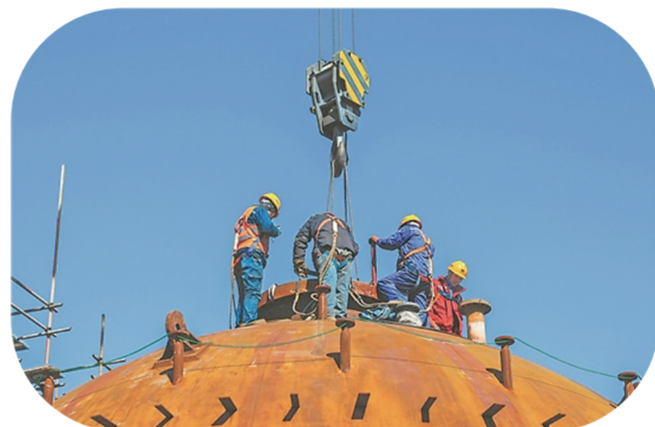
参建员工精心施工，出色完成26万吨/年丙烯腈装置反应单元反应器吊装。
