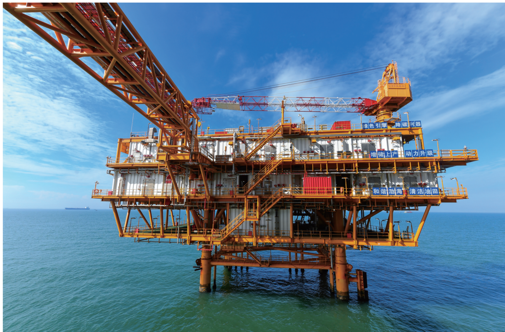
这是9月25日拍摄的连接了岸电的渤海油田海上作业平台(无人机照片)。记者从中国海油天津分公司获悉，截至9月25日，渤海油田岸电应用项目累计供电超30亿千瓦时。岸电是将陆上电网的电，通过海底高压电缆输送到海上油田，供油气开发生产使用。(新华社发(杜鹏辉 摄))
