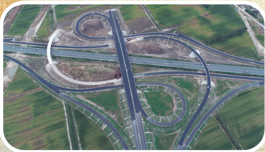
长春都市圈环线高速公路二期K1+500 迟家枢纽互通。
