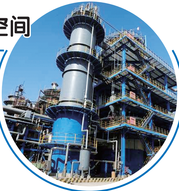
吉林石化炼油厂600万吨/年II常减压装置。
