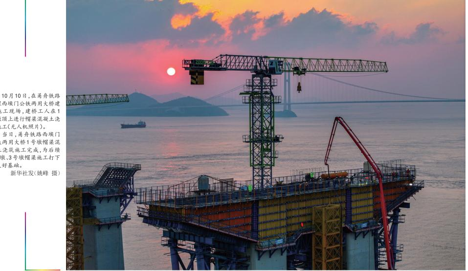
工程西堠门公铁两用大桥建 设施工现场,建桥工人在1 号墩顶上进行帽梁混凝土浇 筑施工(无人机照片)。 当日,甬舟铁路西堠门
